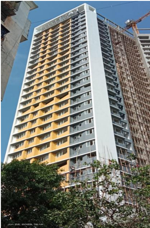
Tenant Building – Ave Maria
